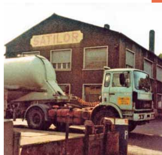
SATILOR construit en 1957, les bureaux
