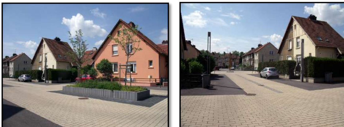
Réaménagement des espaces publics de 2012 : une opération de qualité
