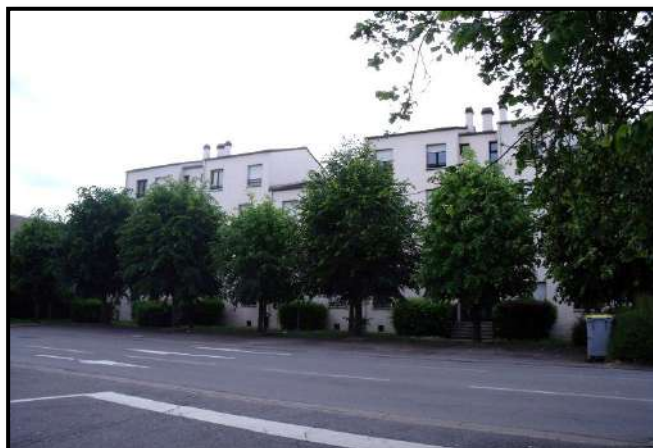
Opération rue du Forgeron
