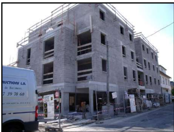
Opération rue Maréchal Foch
