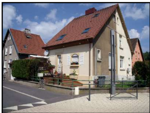
Rénovation partielle de façade
